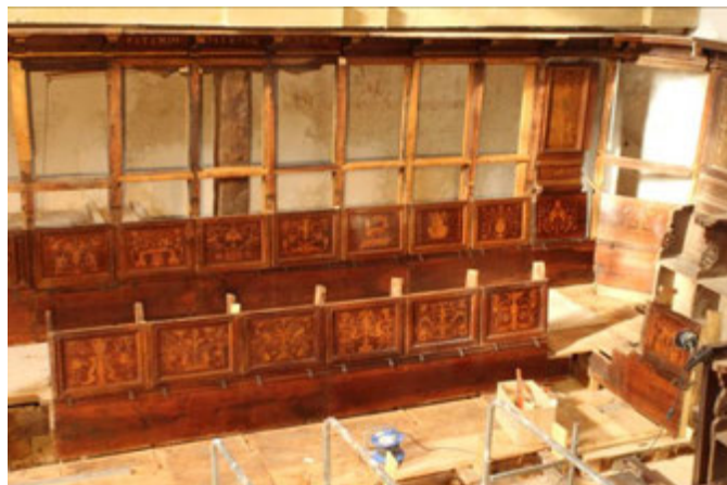
Coro Parrocchia S. Martino “Durante i lavori”
