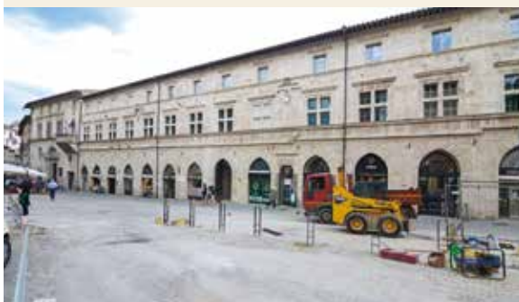
Piazza Matteotti durante i lavori
