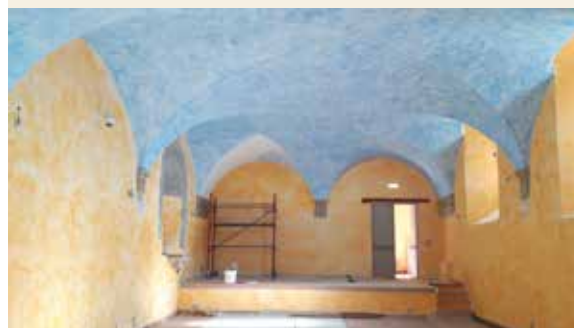
Ex convento degli Olivetani, particolare di una sala
