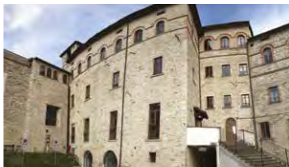
Facciata esterna del complesso.
